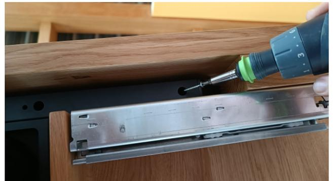
7. Befestigung der Kesseböhmer Adapter mit 2 Linsenkopf-Holzgewindeschrauben. Löcher sind vorgebohrt.
